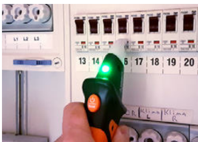
Grüne LED: Sicherung gehört zum gesuchten Stromkreis.
